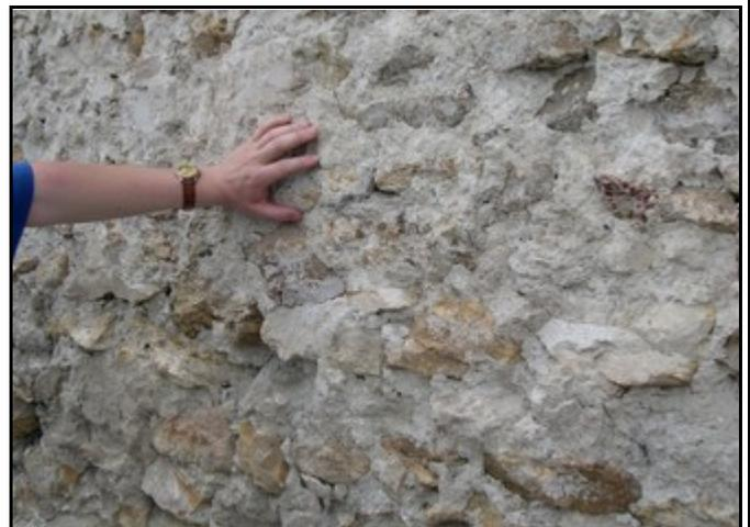
Sous le crépi du mur de façade on peut voir le mode de construction traditionnelle en Paris : des caillasses extraites du sommet de la colline, et hourdées au plâtre. Photo : Laurent Person, 7 juillet 2003.
