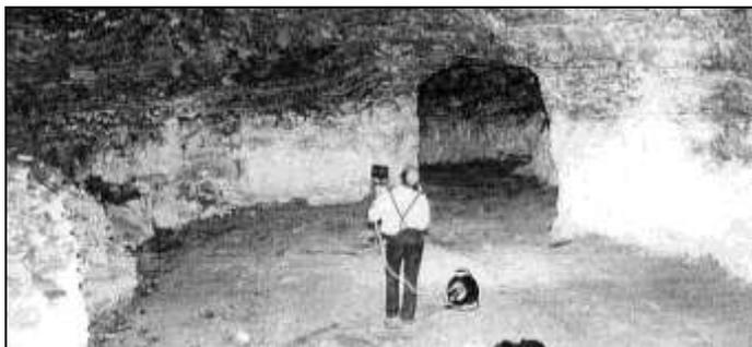
Les fours, capables de sortir jusqu'à 1 000 sacs par jour recevaient le gypse de deux mines communicantes, celle du haut, près de la malterie à 100 m. seulement de celle du bas dont l'entrée est visible à droite du hall voûté actuellement consolidé. Des wagonnets sur voie ferrée amenaient le gypse dès la sortie de la galerie souterraine.
