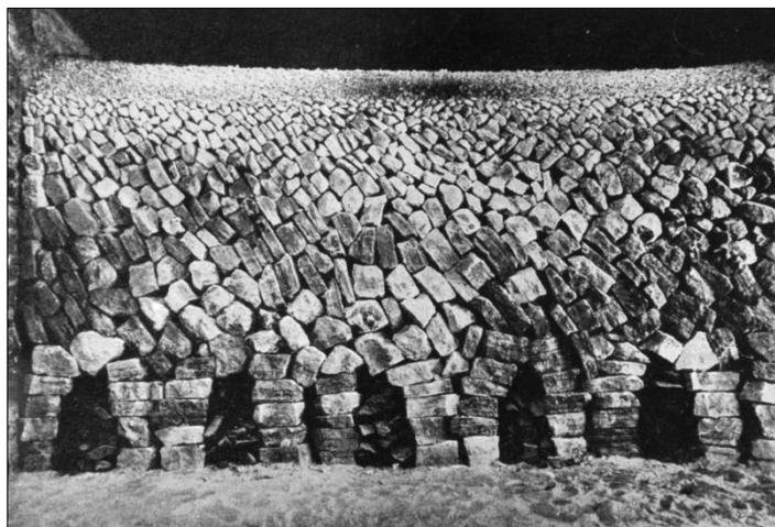
► Empilage des blocs de gypse avant cuisson. Photo extraite de A. Robin, *La Terre*, Larousse, 1925.
