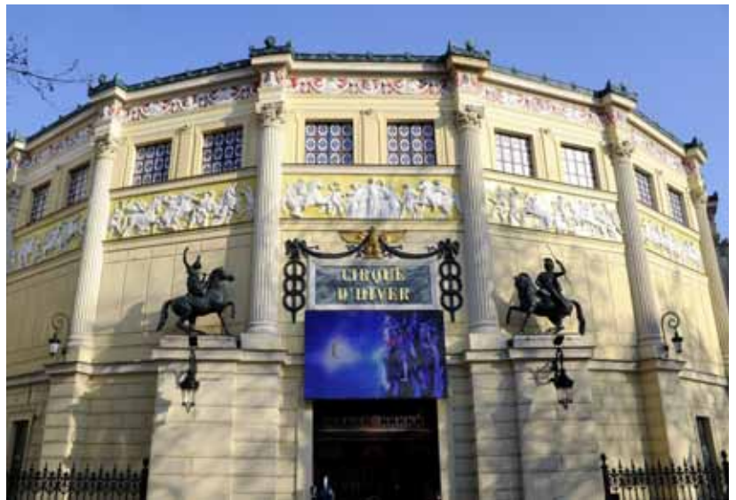
► Les façades du Cirque d'Hiver à Paris, construit en 1852, ont été intégralement restaurées en 2007. Les enduits plâtre chaux teintés de Plâtre.com® se rapprochent des caractéristiques d'origine.
