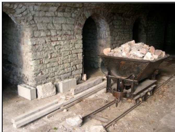
L'intérieur du four de Berzé avec wagonnet sur voie étroite rempli de gypse. Photo Vincent Farion, 2004.
