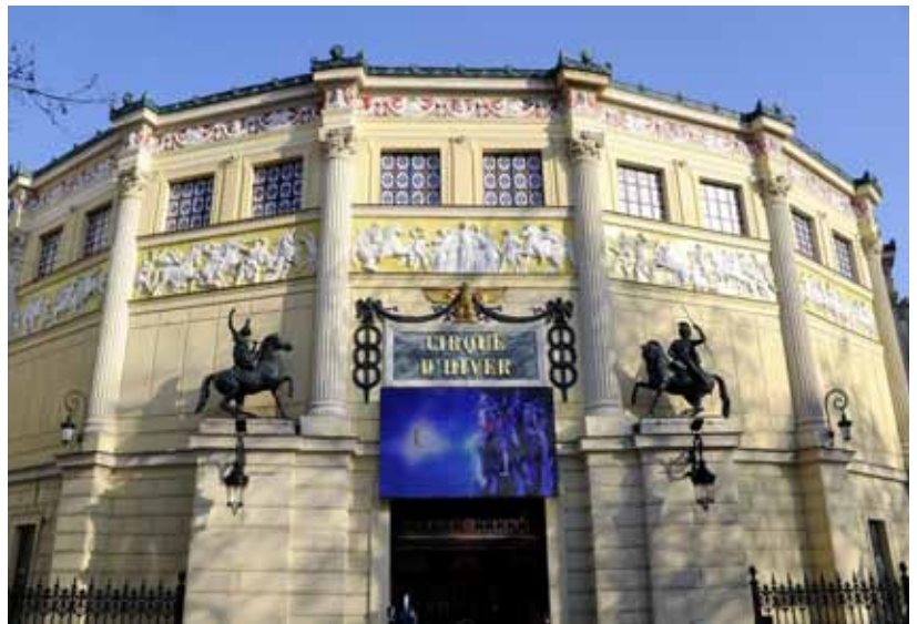
► Les façades du Cirque d'Hiver à Paris, construit en 1852, ont été intégralement restaurées en 2007. Les enduits plâtre chaux teintés de Plâtre.com® se rapprochent des caractéristiques d'origine.
